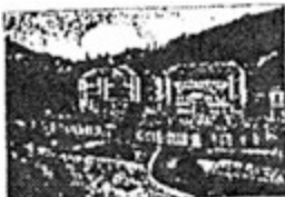
KLEMPIDY HOHEI BESELU-VIA
